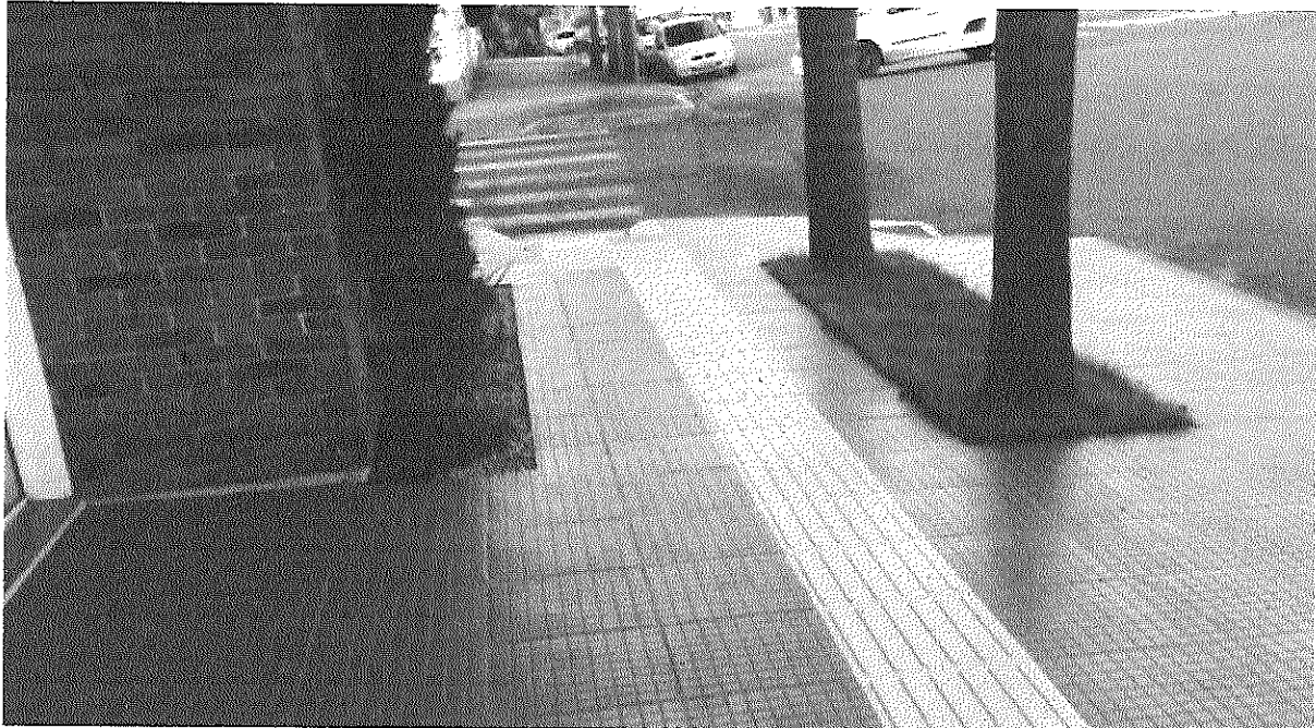
Figura ilustrativa: Piso de concreto xadrez e piso tátil.
